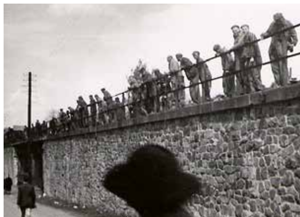
Vězni na viaduktu v Roztokách. I zde dostávali jídlo.
